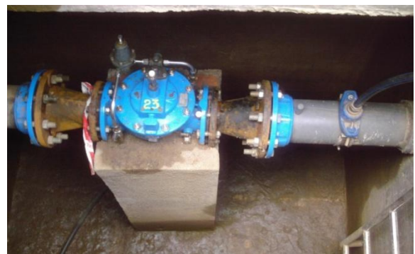
Foto 2. Válvula reguladora instalada en terreno
