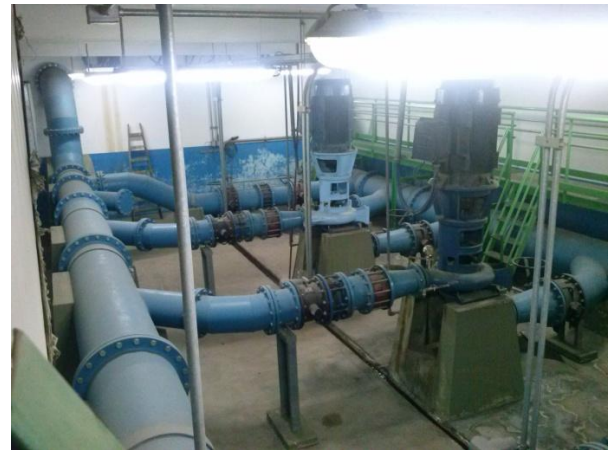
Foto 1. Estación Elevadora Argüello
